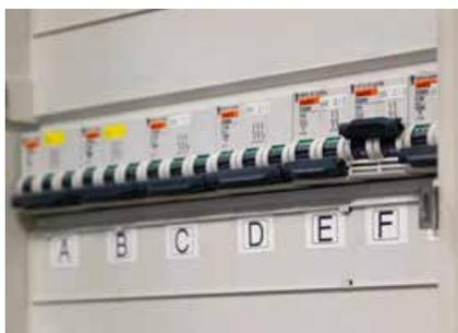
Kennzeichnung von Schutzschaltern
