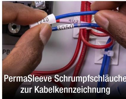
PermaSleeve Schrumpfschläuche zur Kabelkennzeichnung
