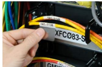
Selbstlaminiierende Leitungs- und Kabelkennzeichnungen
